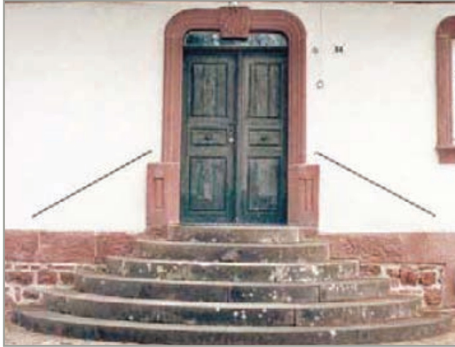
Figure 32 Entrée surélevée (WBW Fortbildungsgesellschaft für Gewässerentwicklung mbH, 2015)
