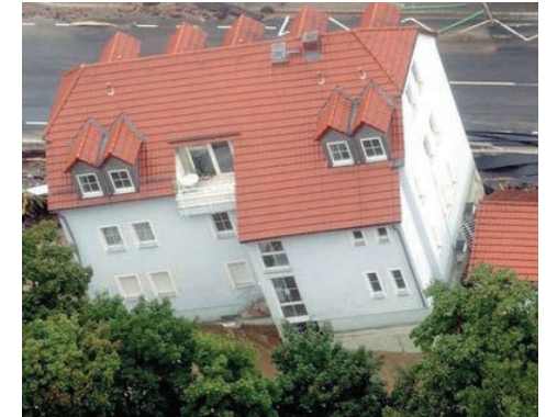
Figure 19 Effondrement d'un bâtiment
