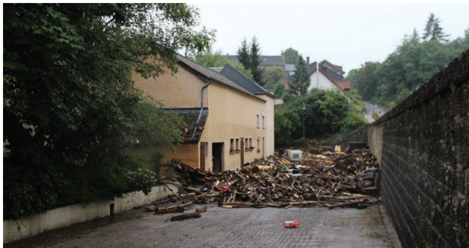
Figure 21 Coulée de débris provoquée par des pluies intenses, 2016
