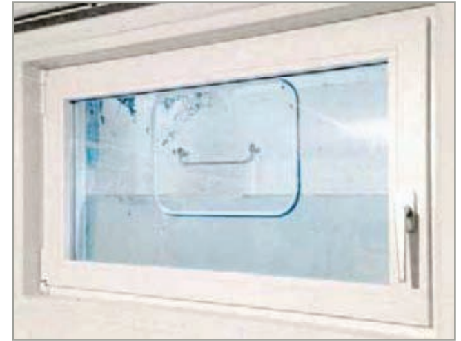
Abbildung 31 Hochwassersicheres Fenster (WBW Fortbildungsgesellschaft für Gewässerentwicklung mbH, 2015)
