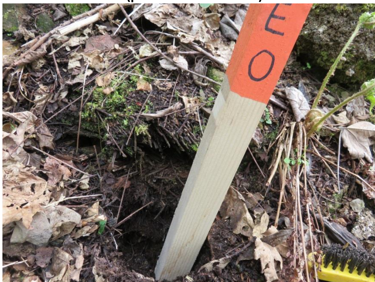
Photos 16 et 17 : E.0 (présence de ferrailles)
