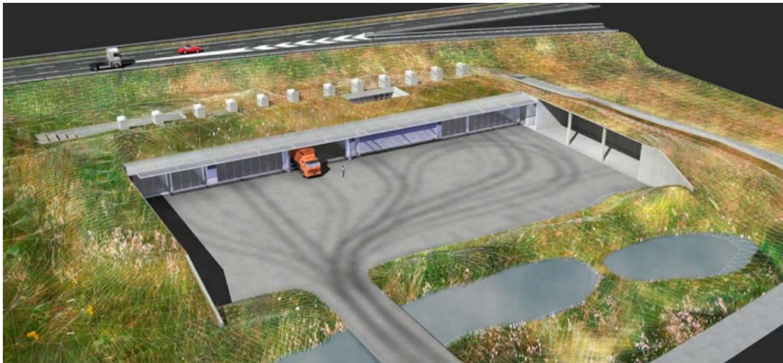
Durch das Eingraben der gesamten Anlage entsteht ein Geländeeinschnitt mit starker räumlicher Wirkung. Die auf drei Seiten durch großzügige Tore abgegrenzte Platzfläche öffnet sich zur Landschaft und grenzt unmittelbar an die durch Modellierung entstandene Retentionsfläche.
