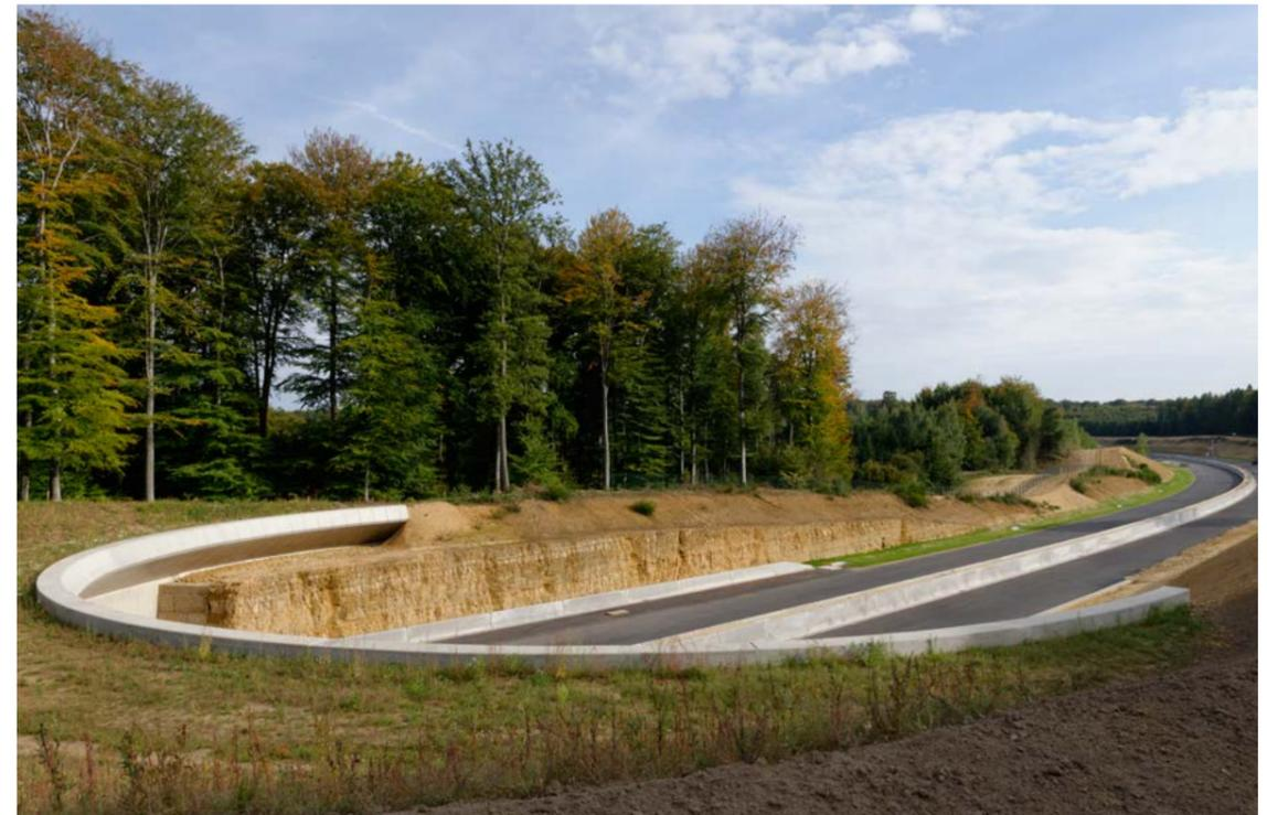
Am Beispiel der Tuneleinfahrt auf dem Heisdorfer Berg ist erkennbar, dass die optimale Bilanz von Aushub- und Auffüllmengen mit der sorgfältig geplanten Lage der Straßentrasse, der Ausgestaltung der Böschungen und der Minimierung von Stützbauwerken zu erreichen ist.
