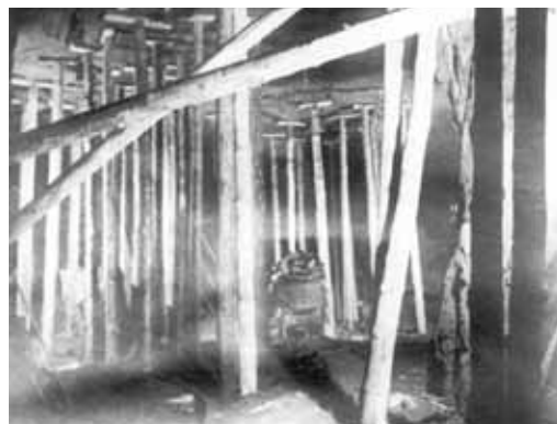
Soutènement en bois d'une galerie
