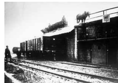
Station de chargement (Tetingen)
