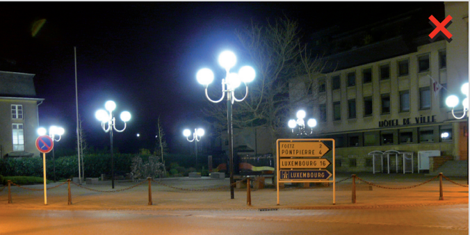
Rundum abstrahlende Kugelleuchten tragen nur teilweise zur Straßen- und Platzbeleuchtung bei. Foto: Guy Spanier, AC Schiffflange
