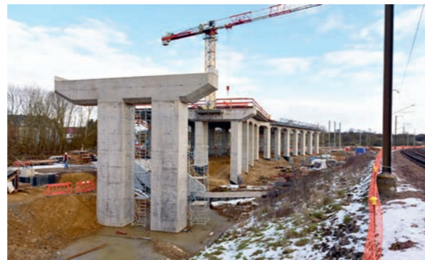
Saut-de-mouton au nord de Bettembourg pour la nouvelle ligne vers Luxembourg (CFL)
