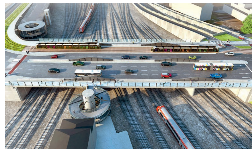
Prolongement de la N3 par le pont Buchler au sud de la Gare Centrale (P&Ch)
