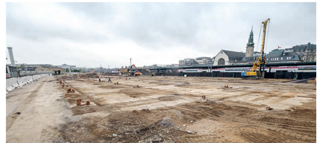
Extension de la gare centrale (CFL)
