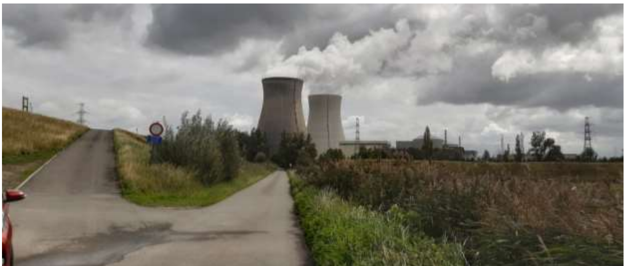
Photo à hauteur du point de prise de vue 2, Scheldemolenstraat (ARCADIS - août 2020)
