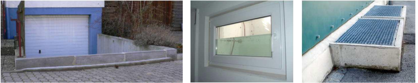
Abbildung 23: Beispiele von festen Objektschutzmaßnahmen
