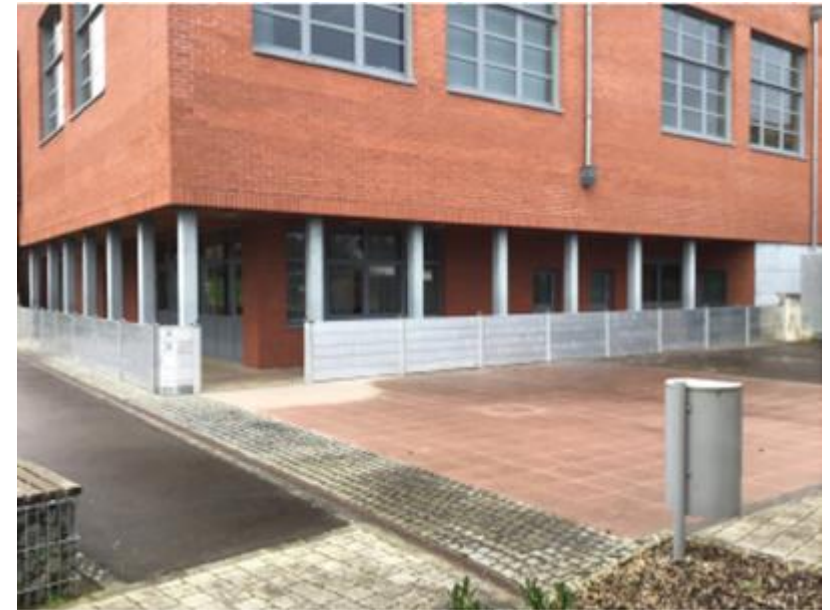
Beispiel Objektschutz des Centre Culturel in Mersch
