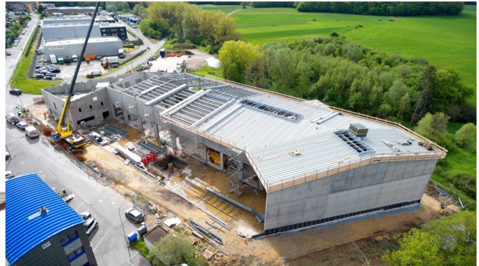
Chantier SICA – © Commune de Kehlen
