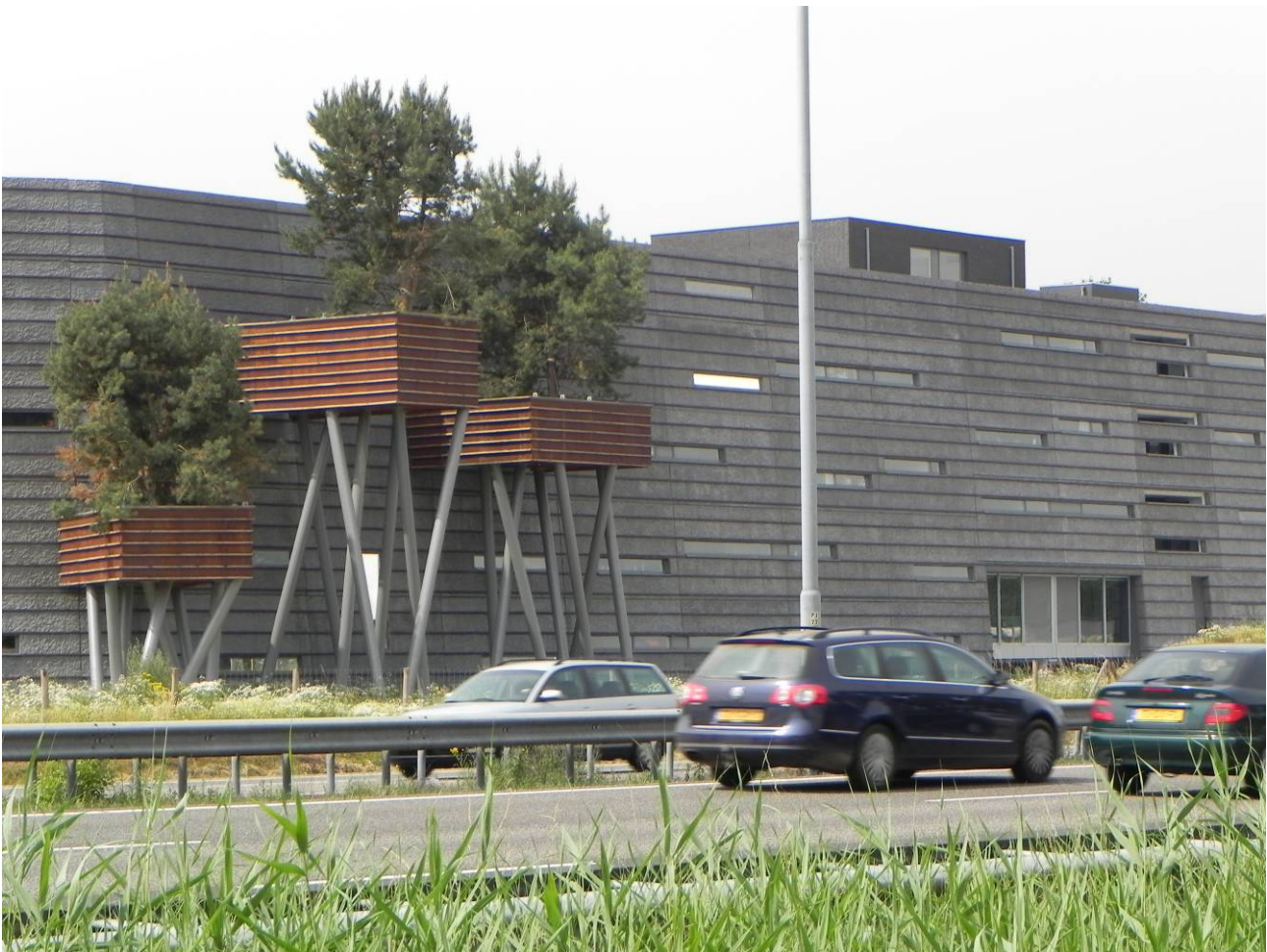
Abb. 44: bewohnte Lärmschutzwand an der A 58 (PRR)
