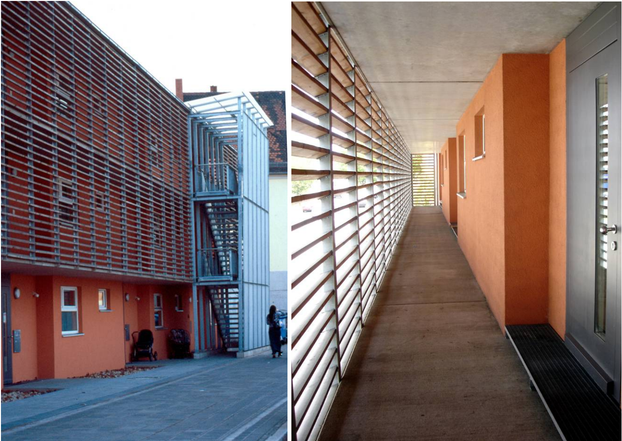
Abb. 96: Ansicht des neuen Wohngebäudes mit dem Laubengang zur verlärmten Gebäudeseite (Ebe +Ebe Architekten + Stadtplaner, München)
