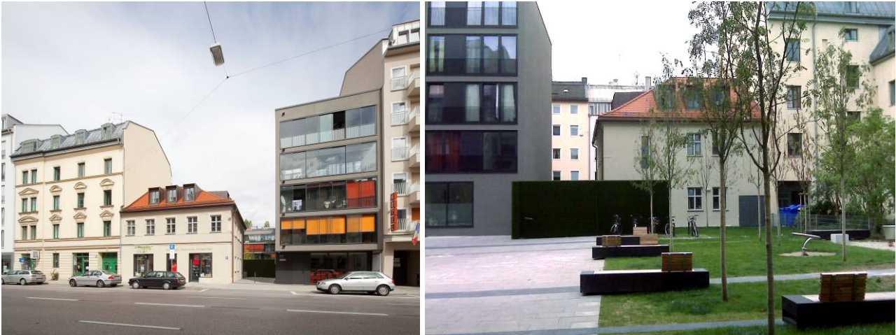
Abb. 100: links – denkmalgeschütztes Gebäude und Ergänzungsbau an der Rosenheimer Straße / rechts – „Grüne Lärmschutzwand“ als Lückenschluss und für Rettungsfahrzeuge beweglich (MGS)
