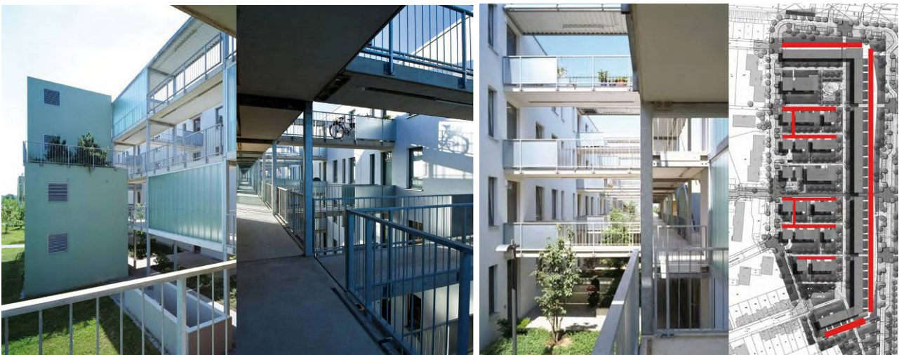
Abb. 38: Die Laubengangerschließung (im Plan rechts rot markiert) bietet Lärmschutz und einen barrierefreien Wohnungszugang. (Dokumentation Deutscher Bauherrenpreis 2010)
