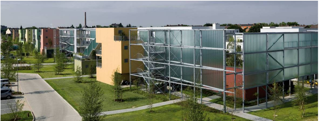
Abb. 37: Schallschutzwirkung durch Erschließungsbauwerke (Agirbas / Wienstroer)
