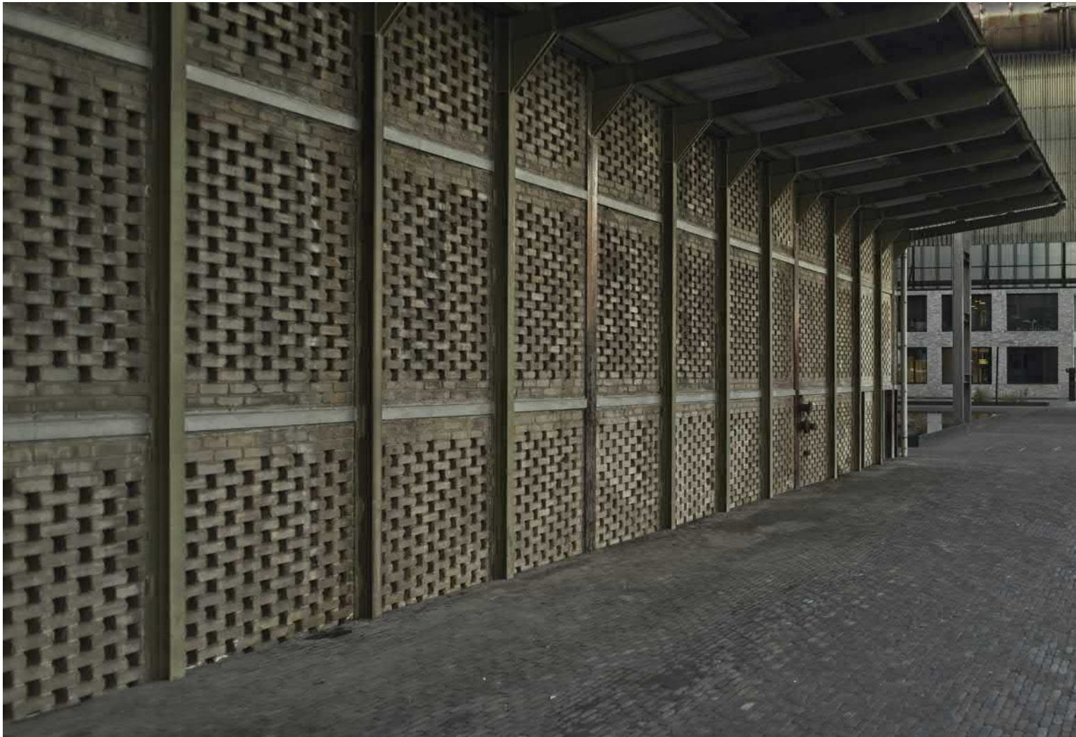
Foto 2: Diese Steinwand bei den stillgelegten Hochöfen von Belval weist ein interessantes akustisches Merkmal auf: Die Hohlräume absorbieren und streuen Schallanteile, während die einzelnen Steine gemeinsam eine größere Fläche bilden und dadurch auch große Schallwellen reflektieren.
