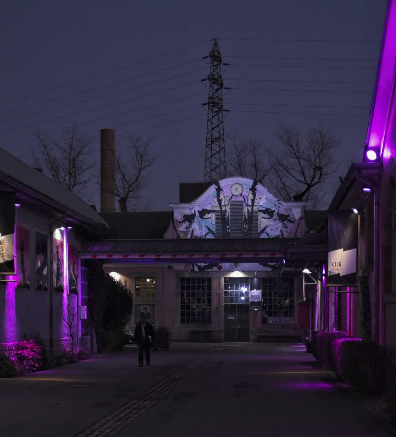
Foto 8: Das alte Schlachthaus von Esch wurde an die Alzette heran gebaut. Heute ist das Areal zur Kulturfabrik umgestaltet, während der Fluss unzugänglich hinter dem Areal durchfließt. Von hier aus starten Besucherinnen und Besucher die Route MEMORIES OF THE BLUE NOISE und folgen dem unterbrochenen Klang der Alzette durch die Escher Innenstadt.
