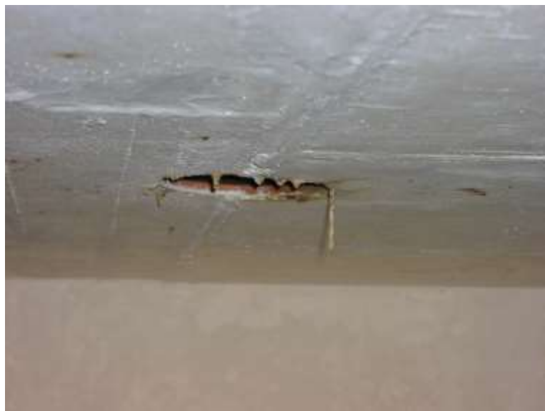
Ventilation au-dessus du plan d'eau
