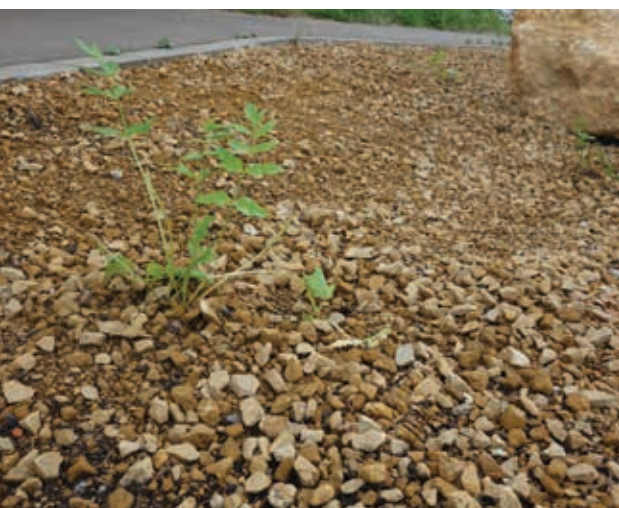
Der Boden wurde mit Kalkschotter der Körnung 0-16 mm ausgetauscht. Initialstauden wurden neben der Einsaat gepflanzt.
