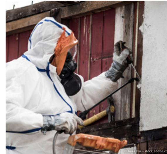
Figure 10 - Prélèvement d'un échantillon de matériaux calorifuges dans le cadre d'un inventaire amiante (l'échantillon sera ensuite soumis à une analyse en laboratoire)
