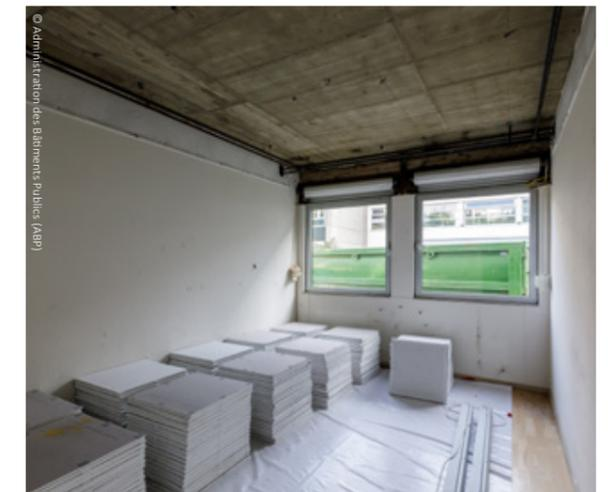
Figure 17 – Dalles de faux-plafond provenant du curage partiel d'un bâtiment – les dalles sont en attente de conditionnement en vue de leur manutention et leur évacuation du chantier
