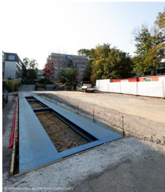
Figure 16 – Installation d'un pont-bascule sur le chantier de déconstruction du Bloc 3000 – Lycée Michel Lucius – Limpertsberg – Administration des Bâtiments Publics (2020)
