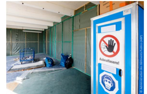
Figure 7 – Travaux de préparation et d'installation d'une zone confinée sur un chantier de désamiantage (image d'illustration)
