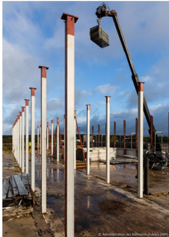
Figure 18 – Illustration d'une déconstruction sélective d'une structure mixte béton-acier – Les colonnes ont été déconnectées et conservées en vue de leur récupération (chantier de déconstruction du Bloc 3000 – Lycée Michel Lucius – Limpertsberg – Administration des Bâtiments Publics (2020))
