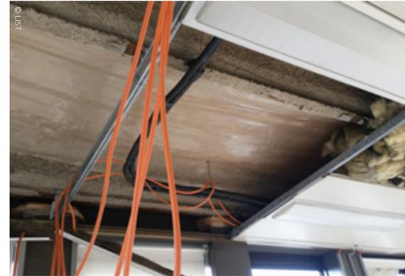
Figure 14 - Illustration d'un test de construction au niveau d'un faux-plafond afin d'accéder à un vide technique (réseaux, câblage, isolation, etc.)
