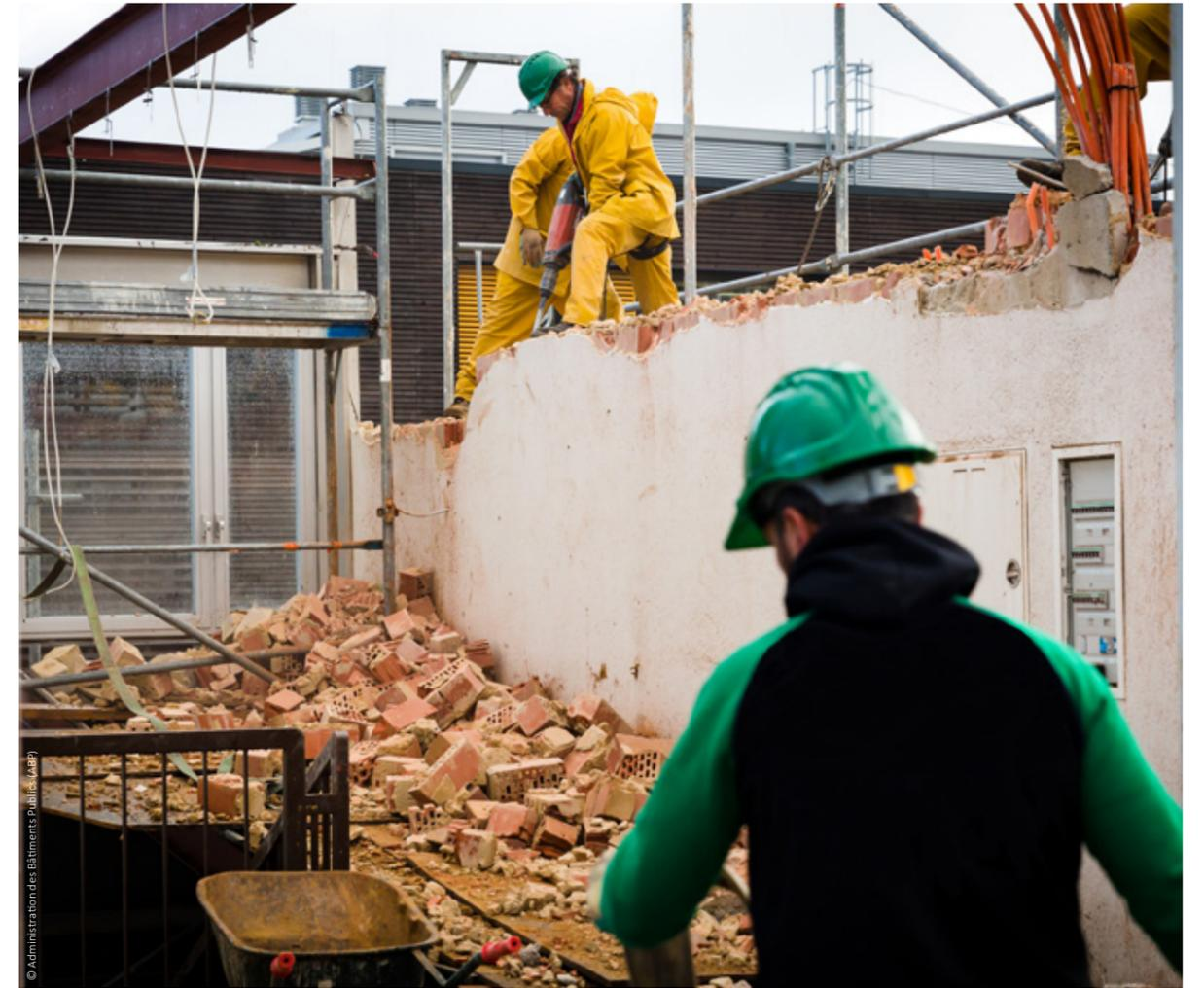
Figure 5 – Illustration des travaux de déconstruction sélective visant la récupération de la structure métallique en vue de son réemploi - chantier de déconstruction du Bloc 3000 – Lycée Michel Lucius – Limpertsberg – Administration des Bâtiments Publics (2020)
