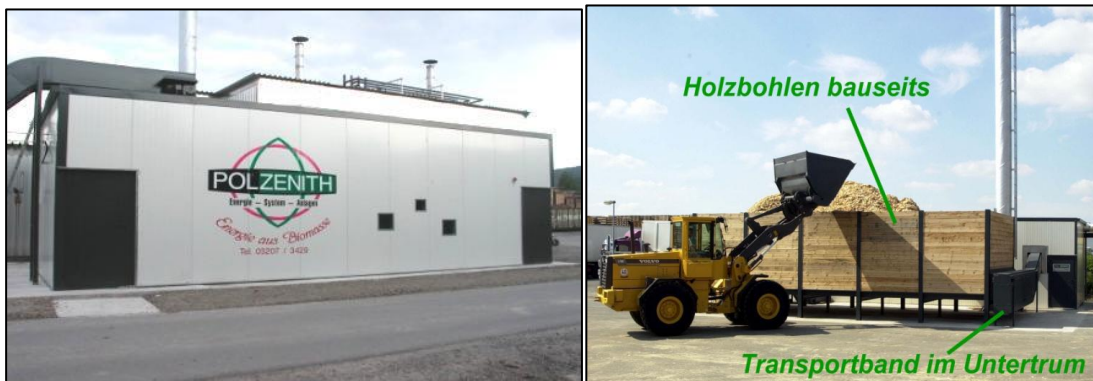
Abbildung 51: Beispiel Containerheizwerk und Vorratsspeicher
