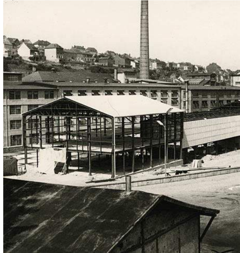
Agrandissement de l'usine « Eurofloor »
