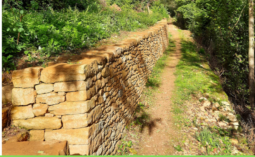
Site pilote de Dieulouard, France © ABPS
