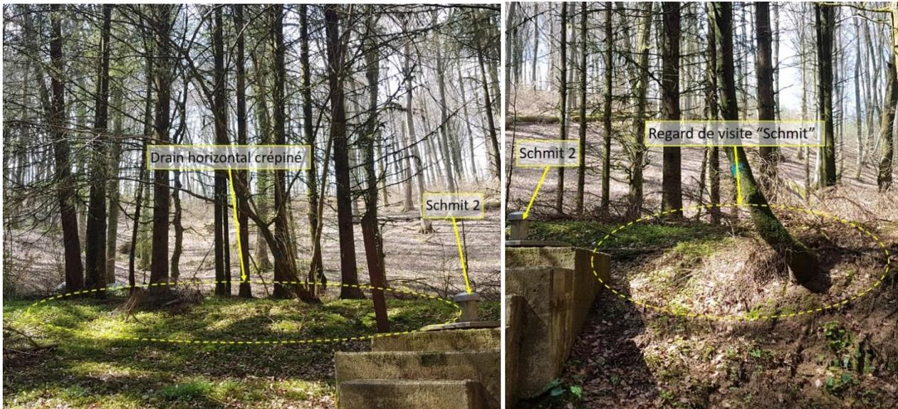
Figure 6. Emplacement projeté du drain horizontal crépiné et du regard de visite
