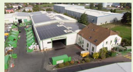
Die 2022 installierte PV-Anlage
