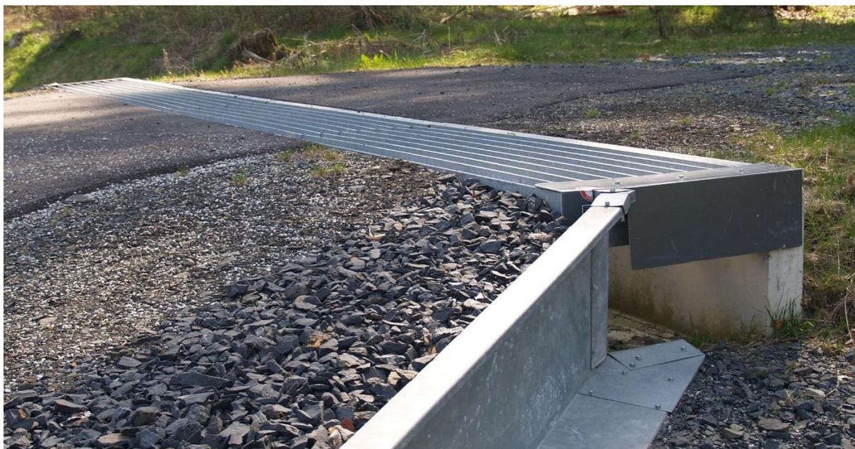
Fig. 24 : Exemple d'un caniveau permettant le passage des amphibiens sous la route. Pour les passages canadiens, le principe à adopter serait le même (volkmann-rossbach, 2023).
