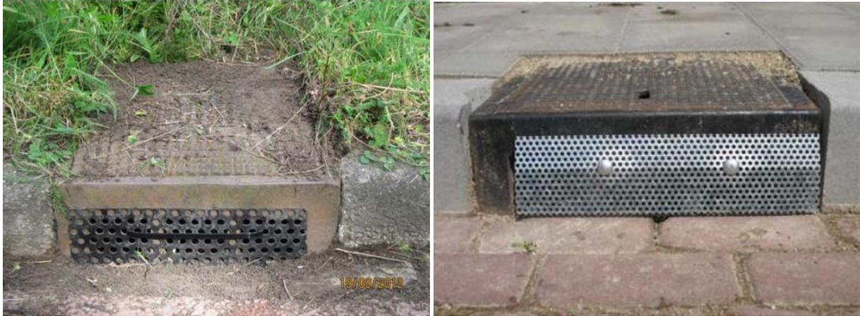
Fig. 2 : Pour les avaloirs dans les bordures, des grilles en plastiques ou métalliques peuvent y être fixées (RAVON 2012).
