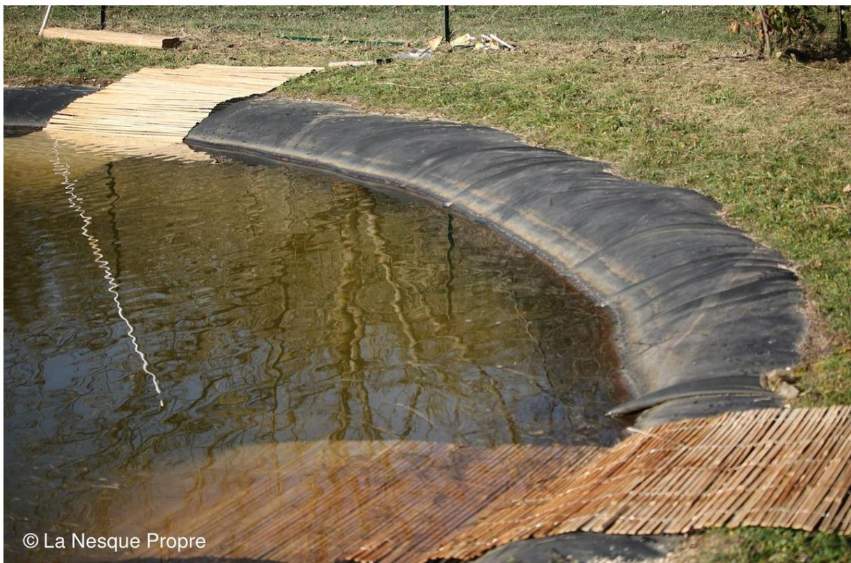
Fig. 17 : Bassin avec des géomembranes glissantes équipé d'« échelles » en tapis de canisses en bambou (La Nesque Propre, 2021).
