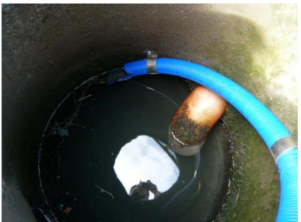
Fig. 15 : Installation d'un tuyau longeant la paroi de l'avaloir depuis le fond de celui-ci et jusqu'au bas-côté de la route (KARCH, 2007).
