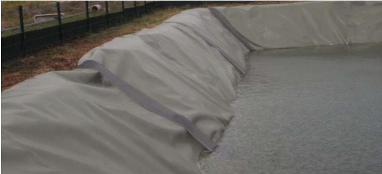
Fig. 18 : Bassin avec des géomembranes glissantes équipé d'« échelles » en géogrilles (Ecosphère).
