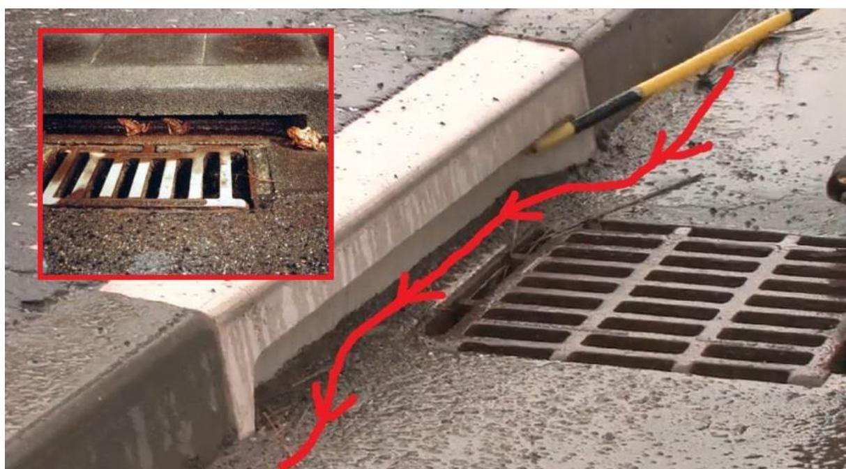
Fig. 26 : La bordure ACO Wildlife Kerb est un dispositif spécifique qui comporte un renforcement sur la face avant pour que les amphibiens contournent l'avaloir (ACO AG, 2023).
