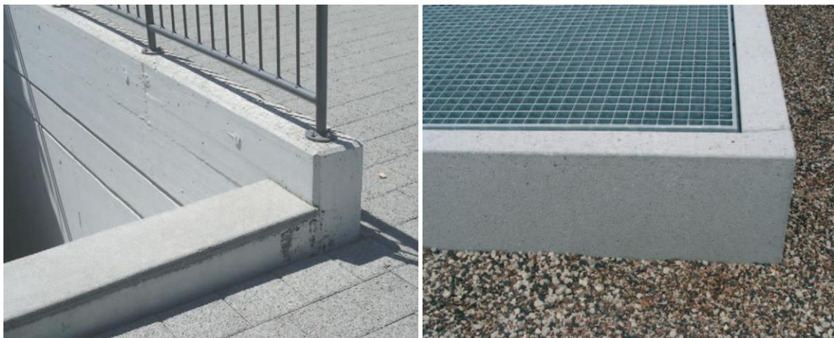
Fig. 33 : Bordure surélevée pour une descente d'escalier (gauche) et pour un puits d'aération (droite) limitant la chute des amphibiens (KARCH, 2016).
