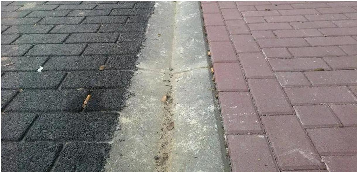
Fig. 29 : Caniveau peu profond à favoriser : aucun effet de barrière ou de guidage n'en résulte (Alberdi 2023).
