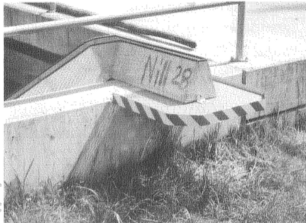
Fig. 21 : Illustration de deux variantes de rampe de sortie. Variante A : pose d'un canal entre la rampe de sortie et le terrain naturel ; Variante B : adaptation du terrain naturel pour une sortie directement en haut de la rampe. La mise en place d'un sceau n'est pas nécessaire si le milieu environnant est adapté. Droite : fin de la rampe de sortie permettant aux amphibiens de tomber dans l'herbe tout en étant abrité des prédateurs (KARCH, 1996).
