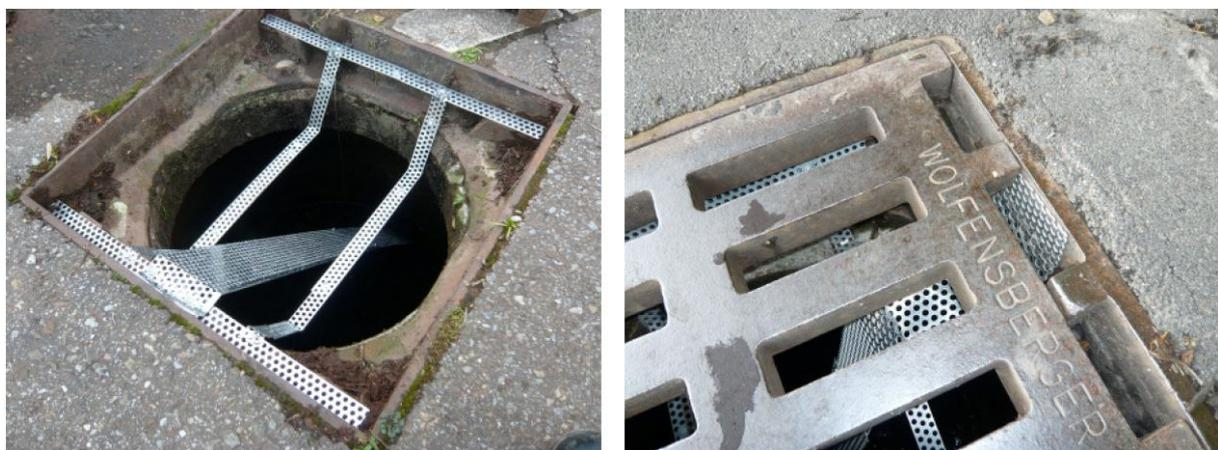
Fig. 12 : Exemple d'une rampe de sortie adaptée à la forme de l'avaloir (KARCH, 2007).
