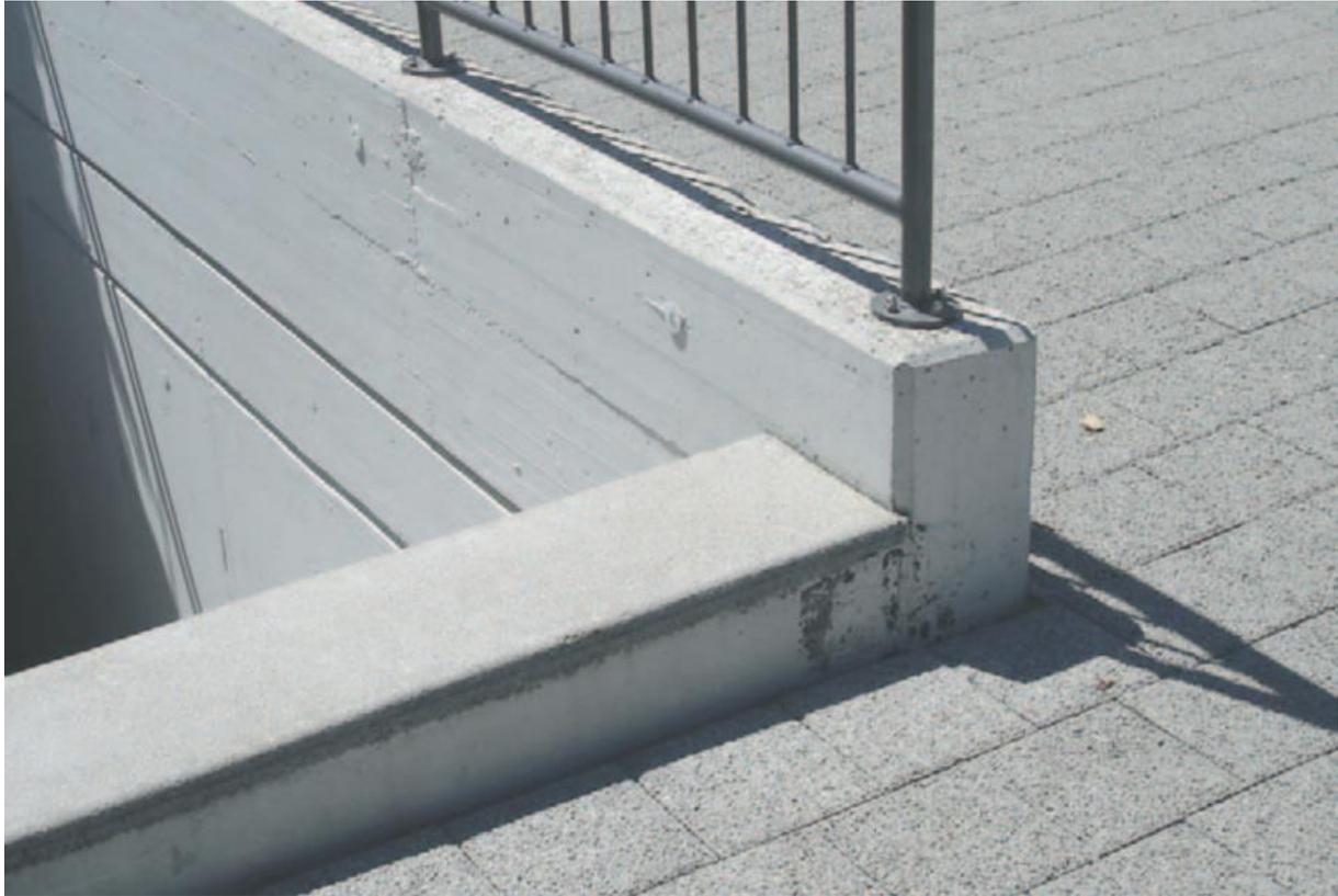
Fig. 9 : Exemple d'une descente d'escalier dont sa bordure est surélevée, minimisant le franchissement des amphibiens (KARCH, 2016).
