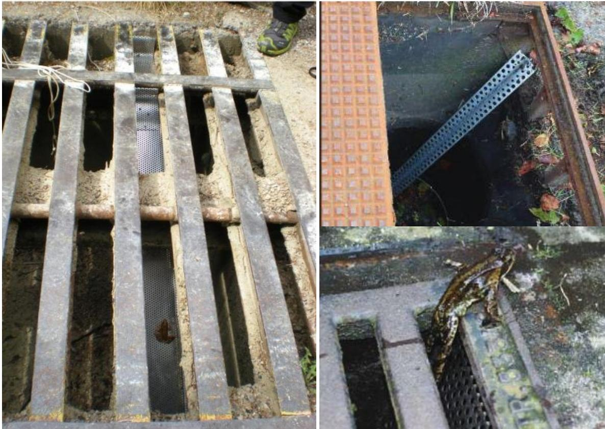
Fig. 11 : Gauche : Rampe de sortie pour les amphibiens dans un passage canadien (co:retis, 2012) ; Droite : Rampe de sortie pour les amphibiens dans un avaloir (Service Public de Wallonie, N.D.).
