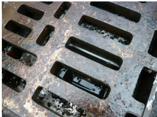
Fig. 14 : Siphon de l'entreprise NILL AG empêchant la chute des amphibiens dans le fond de l'avaloir. Voir également l'entreprise Wildarmaturen (KARCH, 2007).
