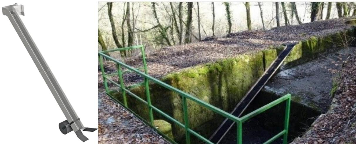
Fig. 19 : Exemples de rampes pour bassin équipées d'un flotteur pour s'adapter au niveau de l'eau. Gauche : Wildarmaturen.ch ; droite : mise en place d'une rampe sur la rigole d'alimentation de Void (55) (Voie navigable de France, 2019).
