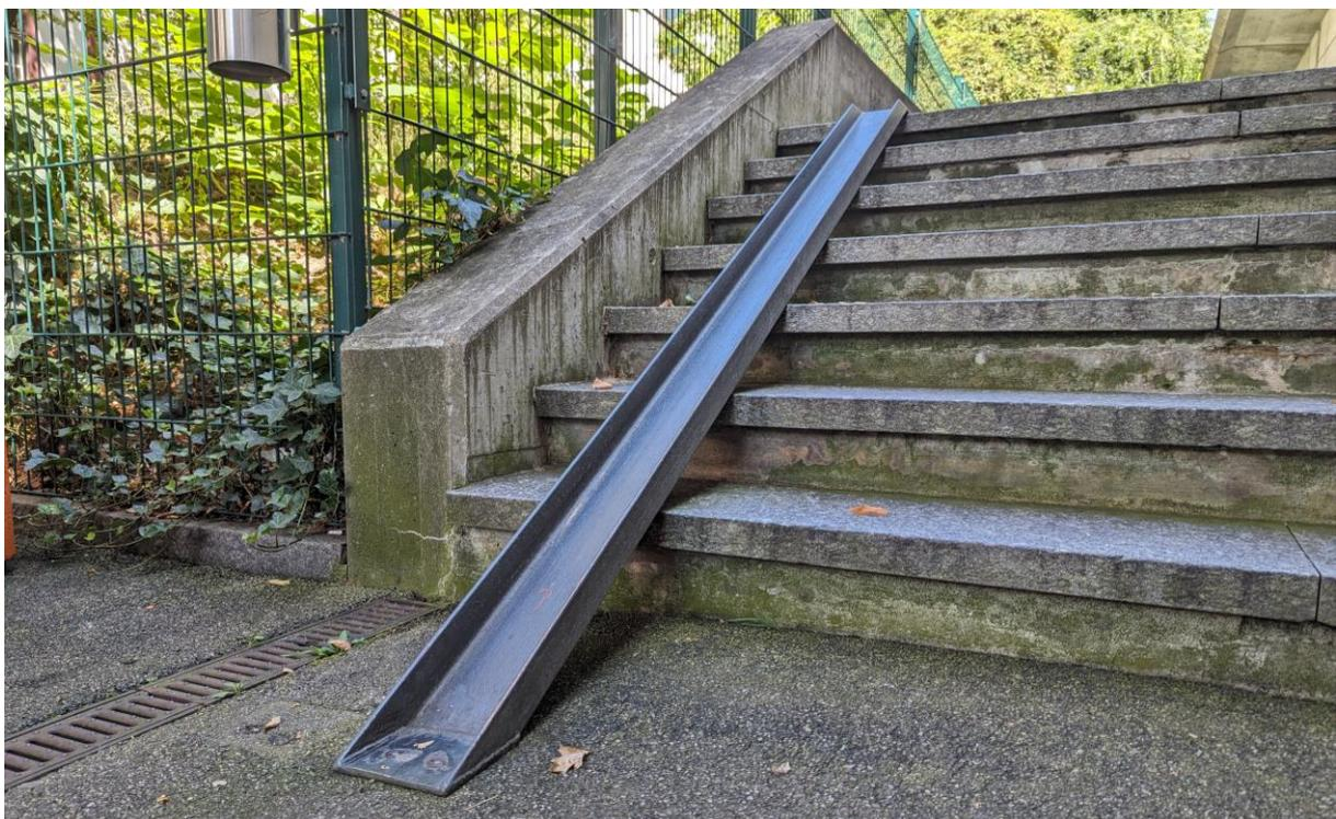
Fig. 23 : Exemple d'une rampe à vélo pouvant servir d'échelle pour les amphibiens. Si la pente est trop raide, une surface rugueuse doit être utilisée pour une meilleure accroche (LUXPLAN S.A., 2023).
