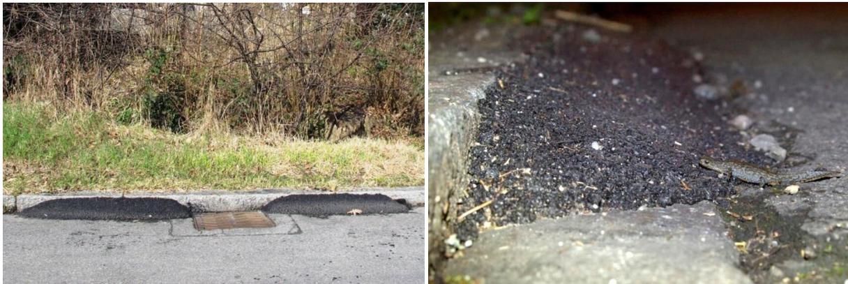
Fig. 5 : Ajout d'une rampe en asphalte de part et d'autre de la bouche d'égout (Grün Stadt Zürich, 2023).
