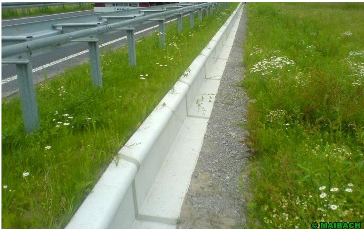
Fig. 8 : Exemple d'une barrière profil en L en béton adaptée aux amphibiens (Mailbach, 2023).
