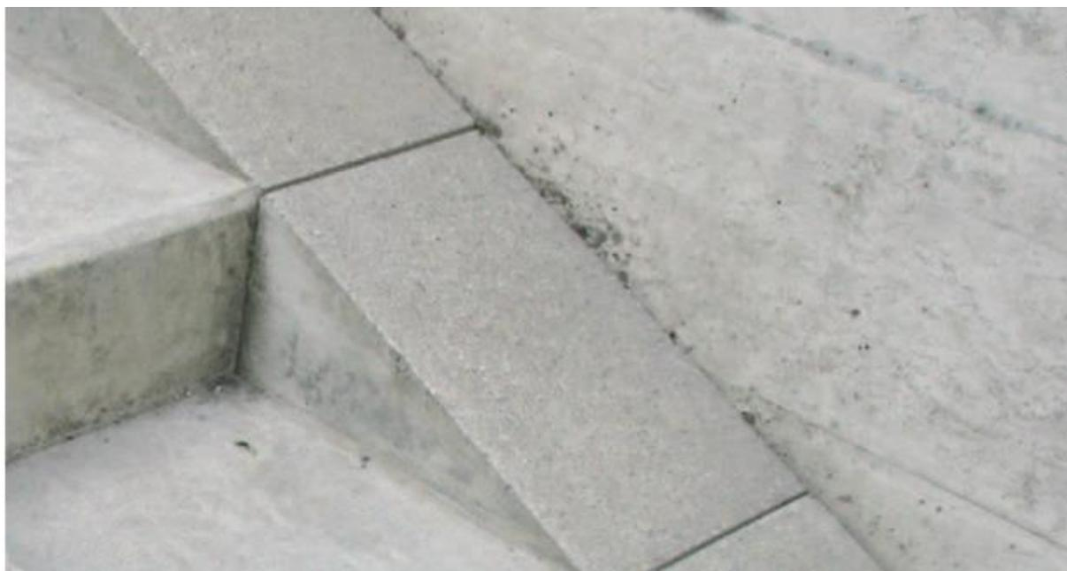
Fig. 34 : Rampe intégrée entre les marches d'escalier et la bordure de l'escalier permettant la remontée des amphibiens (KARCH, 2016).
