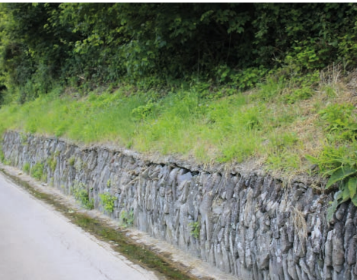
Muret en pierre sèche
