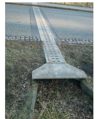
Exemple de tunnel pour amphibiens
