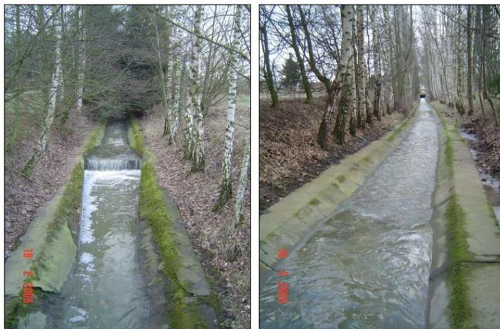
Le projet de renaturation consistait en différentes mesures telles que la suppression du canal en béton et le reméandrage du cours d'eau. Différentes structures seront mises en place, mais sans organisation systématique pour laisser le cours d'eau dans son auto-développement naturel qui permettra d'accentuer les mesures effectuées. Des mouilles (dans les rives concaves des méandres) et de radiers (au point d'inflexion d'un méandre) ont été créés dans le lit du cours d'eau en vue de créer des
