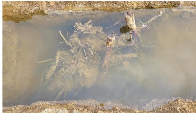
Pendant la phase de chantier, des mesures de protection contre la mise en suspension des sédiments ont été mises en œuvre. Des bottes de paille ont été placées dans le cours d'eau. Les travaux ont été réalisés autant que possible à sec.
