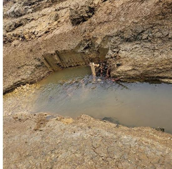
Des éléments de structure, tels que des souches et des troncs d'arbres, ont été ajoutés au lit du cours d'eau « Dipbech » après avoir déterminé les emplacements appropriés en fonction des caractéristiques du terrain et des objectifs visés (création d'habitats aquatiques ou protection des berges).
