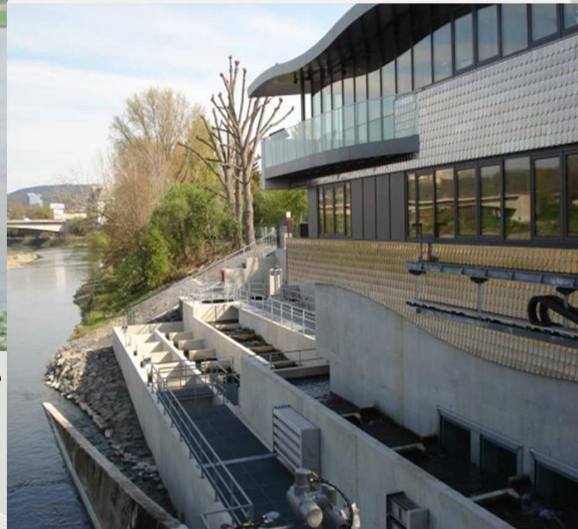
2011: Passe à poissons avec centre de visite „Mosellum“ à l'écluse de Coblenche (D)
