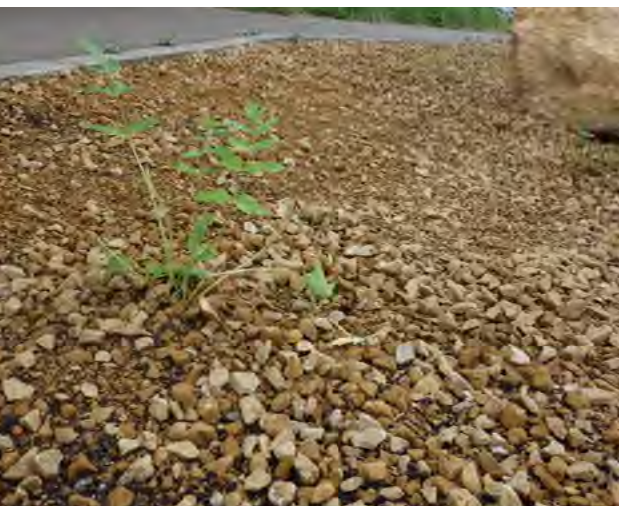
La terre a été remplacée par du gravier calcaire d'une granulométrie comprise entre 0 et 16 mm. Des vivaces pionnières ont été plantées en plus du semis.
