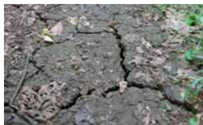
Fissures dans le sol argileux
