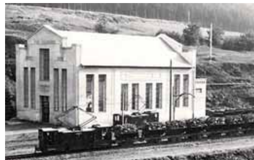
Centrale Heintzenberg du puits Heintzenberg 22
