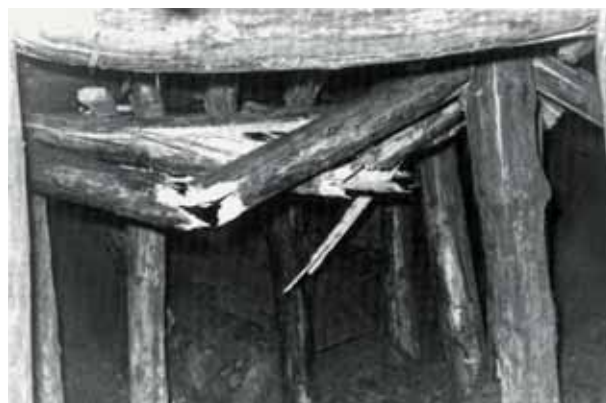
Effondrement d'une galerie souterraine 40
