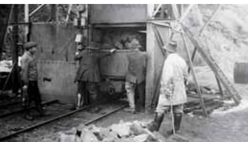
Chevalement de la Mine Heintzenberg
