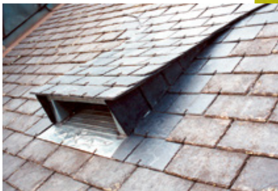
Chiroptère installée sur le toit de l'église de Dippach dans le cadre du projet « Combles & Clochers ».
