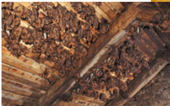
Colonie de mise-bas du Grand murin dans les combles d'église.
