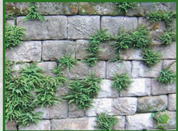
Trockenmauern aus lokalen Steinen oder aus Drahtschotterkörben (Gabionen) sind ökologisch wertvoll und im Selbstbau billiger als gemauerte Mauern.
