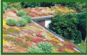
Dachbegrünung als Mittel der lokalen Rückhaltung von Regenwasser
