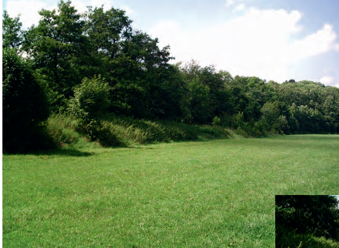
Plaine alluviale avec digue
