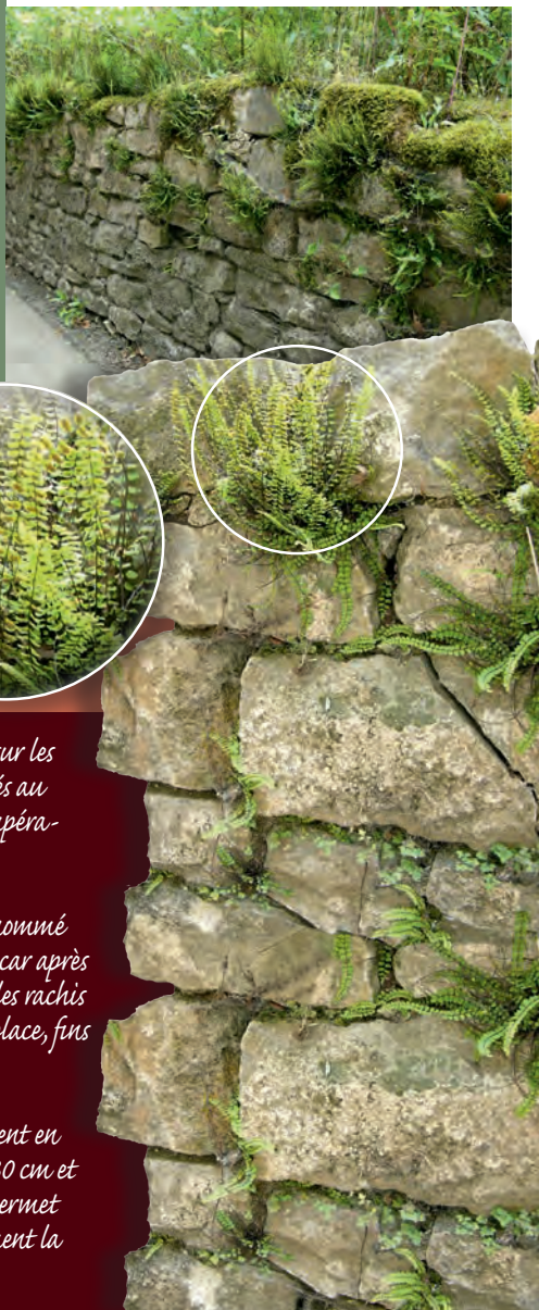
Capillaire des murailles (Asplenium trichomanes) sur mur en maçonnerie sèche
