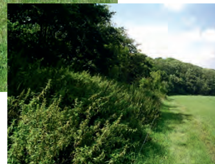
Vue latérale sur la digue recouverte d'orties
