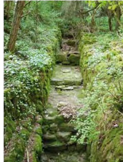
*Der aus standörtlichem Gestein gebaute Abflusskanal ist auch heute noch vorhanden und funktionsfähig.*
