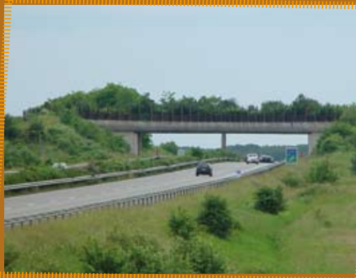
Wildbrücke über die A1 nach Trier.
