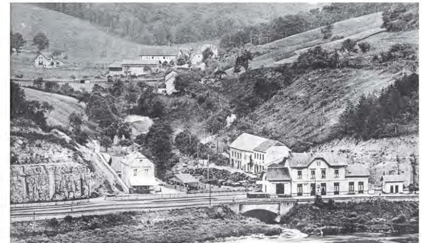
Grundhof gelegen, in ihrer Funktion als Industriebahn und wurde später bis nach Beaufort weitergebaut. Auf einer Länge von insgesamt 7,37 km schlängelte sich die Bahn hinauf nach Beaufort und musste dabei fast 200 Höhenmeter überwinden. Mit Hilfe von drei Spitzkehren konnte das Problem gelöst werden. Sie diente sowohl dem Güter- als auch dem Personenverkehr.
