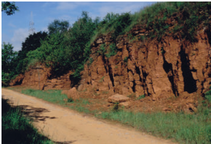
Abb. 26: Freigestellte Abbruchkante (NSG Haardt, 31.05.2006; Foto: Josy Cungs).
