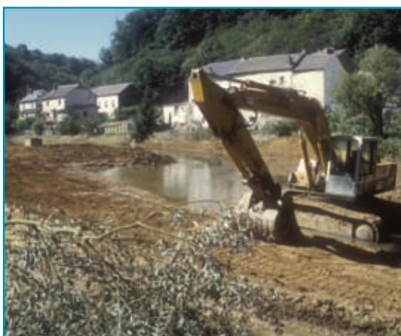
Travaux de rehaussement du fond et d'élargissement du lit de l'Alzette à Hesperange.
