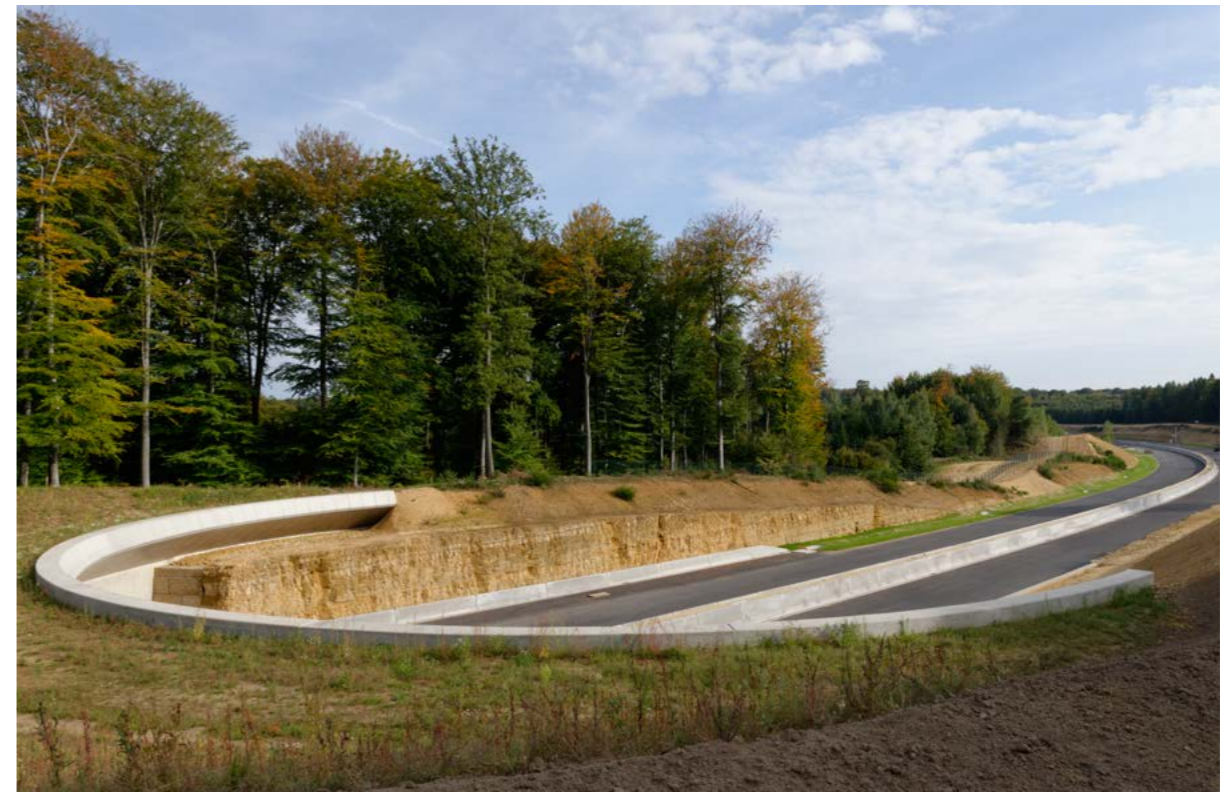
Am Beispiel der Tunnelfahrt auf dem Heisdorfer Berg ist erkennbar, dass die optimale Bilanz von Aushub- und Auffüllmengen mit der sorgfältig geplanten Lage der Straßentrasse, der Ausgestaltung der Böschungen und der Minimierung von Stützbauwerken zu erreichen ist.
