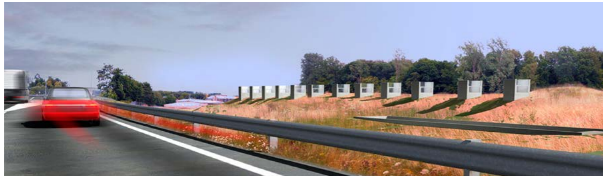
Entlang der Autobahn nimmt man das recht große Gebäude nicht wahr. Es ist eingegraben und sein Dach besteht aus einem lang gezogenen Erdwall aus dem lediglich die Oberlichter ragen, um die darunter liegenden Hallen mit natürlichem Tageslicht zu versorgen.
