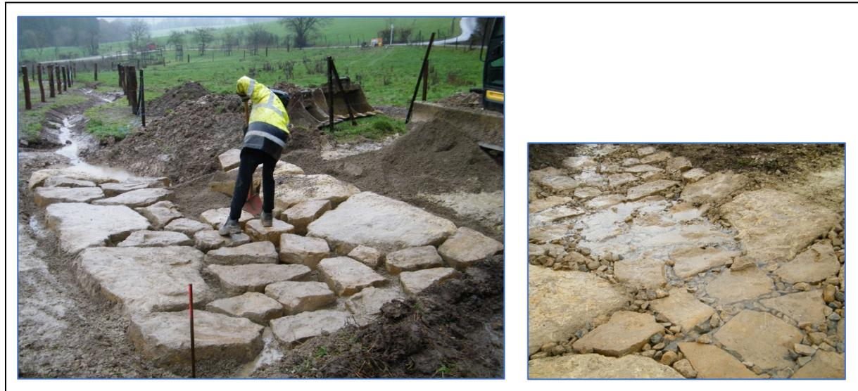
Abbildung 53: Neubau einer Furt in Givenich, Gem. Rosport-Mompach, Foto Ä.Erpelding
