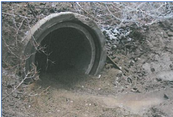
Abbildung 43: Überdimensioniertes Stahlbeton-Rohr mit durchgängigem Substrat
