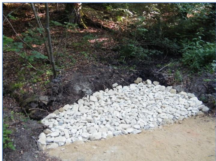
Abbildung 51: Quelle an der Riedelbaach, Auslauf der Sickerrolle mit fließendem Übergang in bestehenden Bach. - Mamertal
