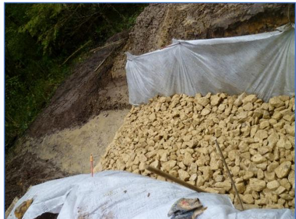
Abbildung 50: Sickerrolle beim Einbau, unterhalb des Weges mit durchlässigem Schotter 50/100. Riedelbaach – Gem. Kehlen (Fotos Ä. Erpelding)
