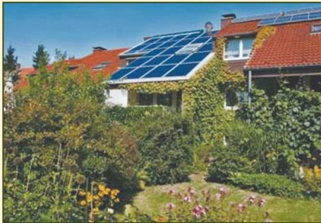
Fotovoltaikanlagen, einmal als Dachabdeckung (Bildmitte) und einmal als Aufdachmontage (Haus rechts)
