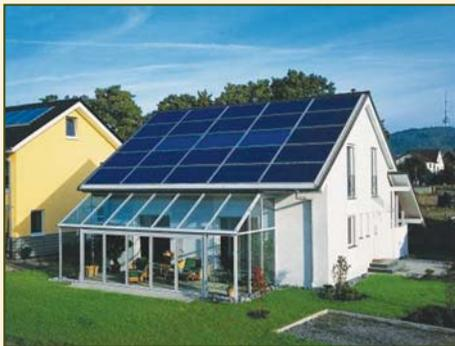
Fotovoltaikanlage als Dachabdeckung, thermische Solaranlage in der Mitte (Hellblau)
