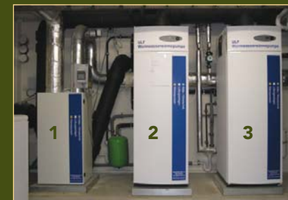
Installation de chauffage central dans une maison passive
