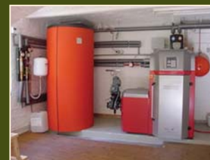
Chauffage central à granulés de bois
