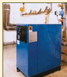
Pompe à chaleur
