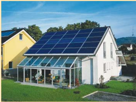
Installation photovoltaïque en couverture de la toiture, collecteurs solaires thermiques (en bleu clair)
