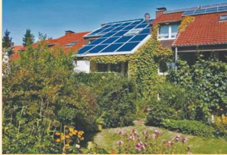
Installations photovoltaïques en couverture de la toiture (au centre), montée sur la toiture (à droite)
