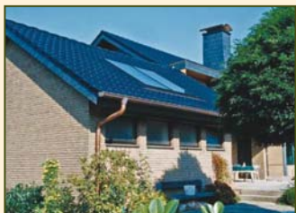
Collecteurs solaires thermiques pour la production d'eau chaude sanitaire, intégrés dans la toiture
