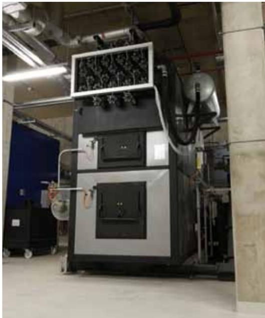
Hackgutkessel 750 kW der Anlage Ecole Européenne 2
