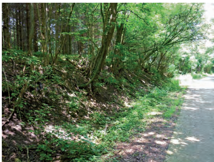
Talus le long d'une piste cyclable
