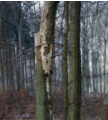
LES ARBRES FORTEMENT CHAMPIGNONNÉS N'ONT MÉME PLUS AUCUNE VALEUR COMME BOIS DE CHAUFFAGE DU FAIT QUE LES FIBRES DU BOIS SONT DÉJÀ FORTEMENT DÉCOMPOSÉES, ALORS QUE L'ARBRE EST ENCORE DEBOUT
