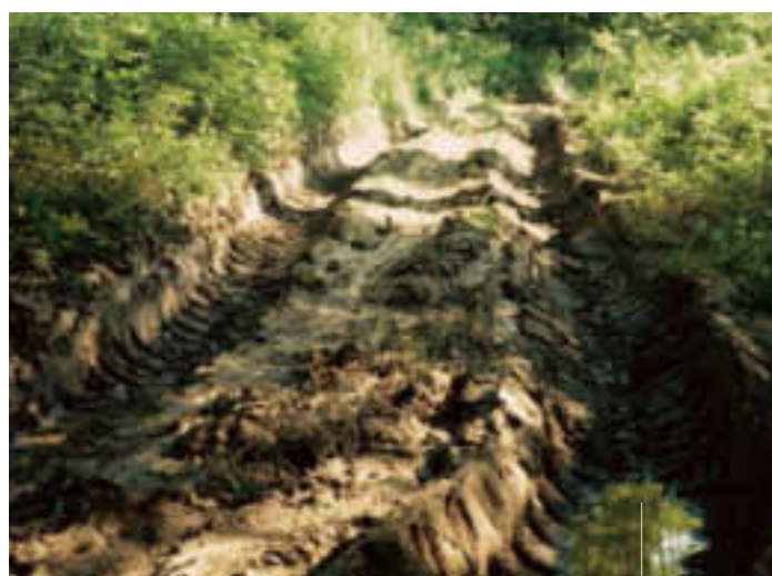
ORNIÈRE RÉSULTANT DU PASSAGE D'UN TRACTEUR FORESTIER
