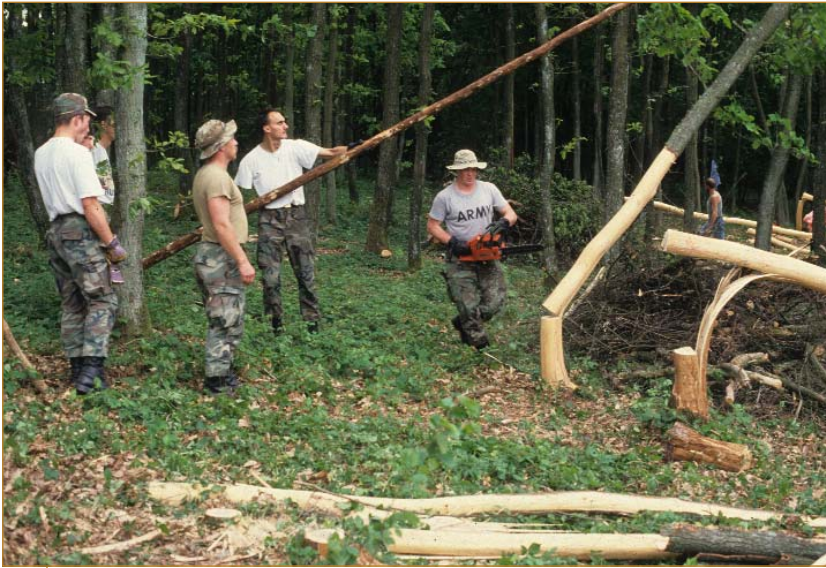
Beim Fällen wird der Baum nicht ganz vom Wurzelstock abgetrennt
